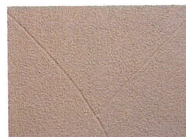
Uカット工法
