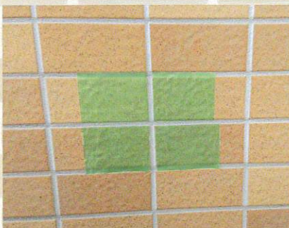
1 パイオランテープをタイルに貼り付ける
