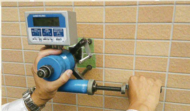
4 引張試験器テクノスター RJ-1 にて目地モルタル強度確認試験を行う
