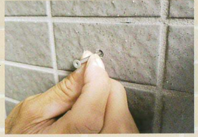
⑥ GNSアンカー挿入
