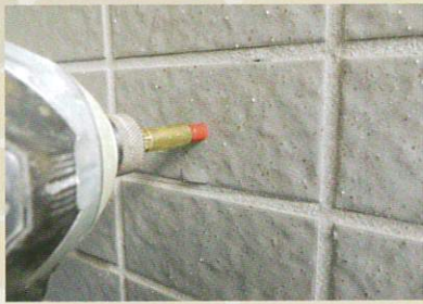
④ 座掘り作業
