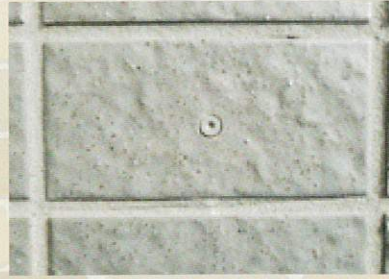
⑧ GNSアンカー打込み完了
