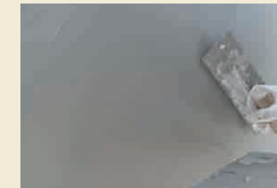
5. GNSフィラーP上塗り
