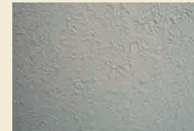
6. 新規仕上材の施工
