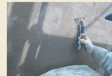
2. GNSフィラーPT塗り+GNSネット埋込み
