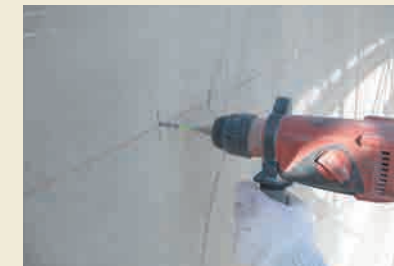
3. GNSアンカーピン穿孔作業
