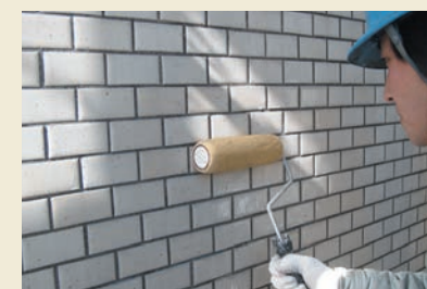
1. GNSプライマー塗布
