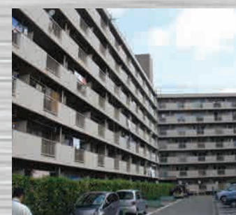
現場全景 (千葉県某物件)
