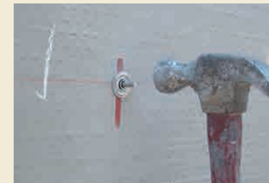
4. GNSアンカーピン打込み作業
