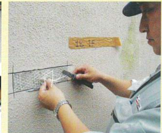
GNSネット抜き取り
