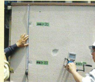
GNSアンカーピン引張試験
