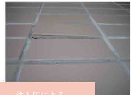
注入圧による タイル剥離や目地破壊
